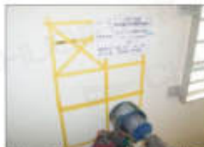
耐震調査コア採取時の鉄筋等切断の防止
