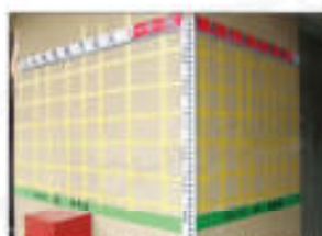
既設建物の柱配筋調査
