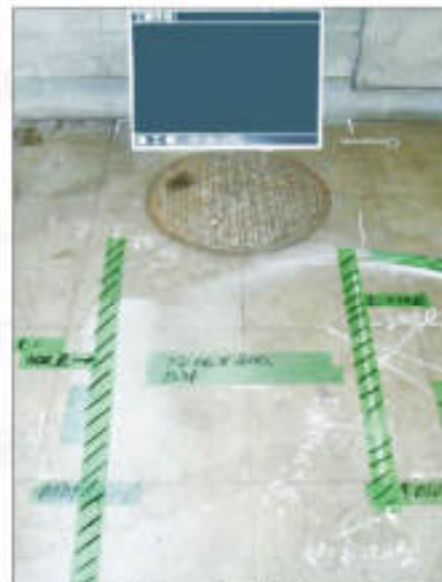
シンダーコンクリートの埋設配管調査
