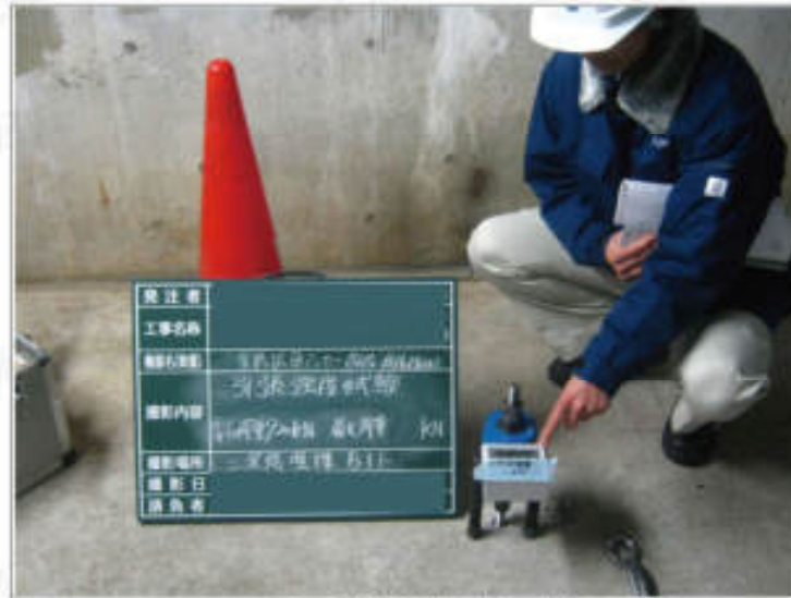
アンカー引張試験(施工状況確認)
