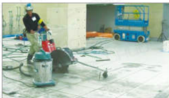
重量を考慮し、搬出可能な大きさに分割するため、基盤の目状にカッターを入れます。
