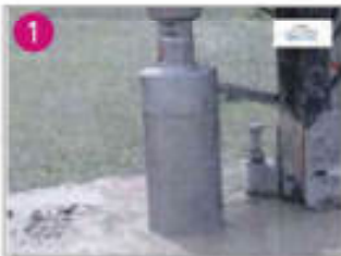
1 バースターヘッド挿入孔の穿孔
