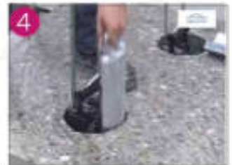
4 プッシャープレート挿入
